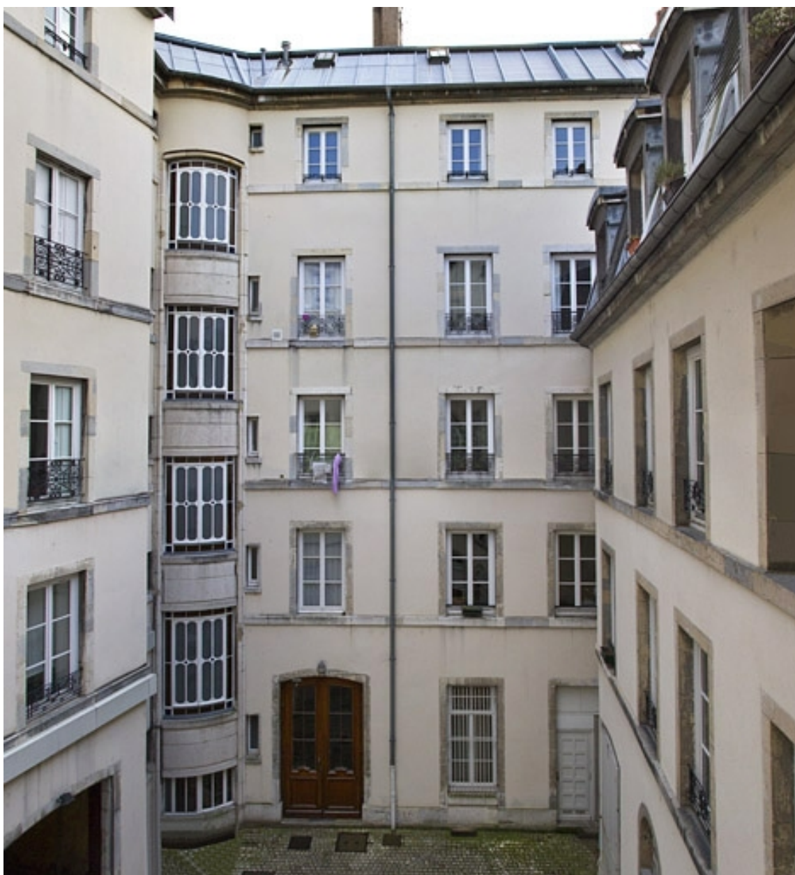
Logis principal, façade postérieure, côté rue Morand.
