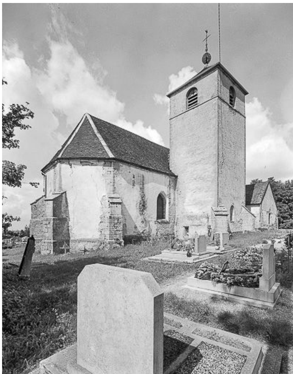
Façade latérale gauche vue depuis l'est.
