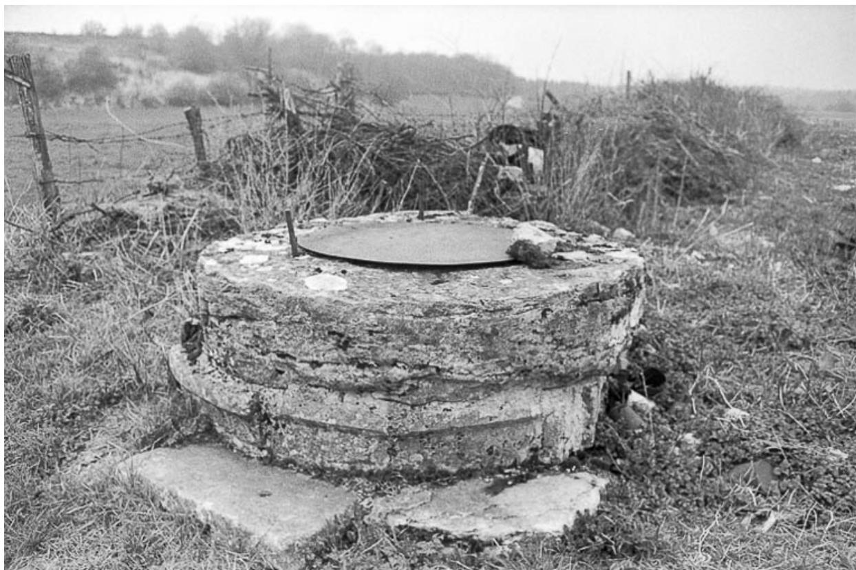
Puits dit puits "romain".
