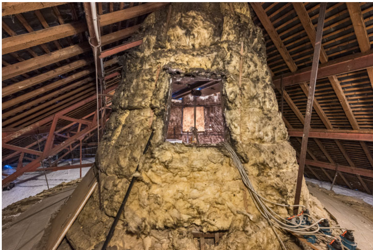
Comble de la salle : cheminée d'aération.
