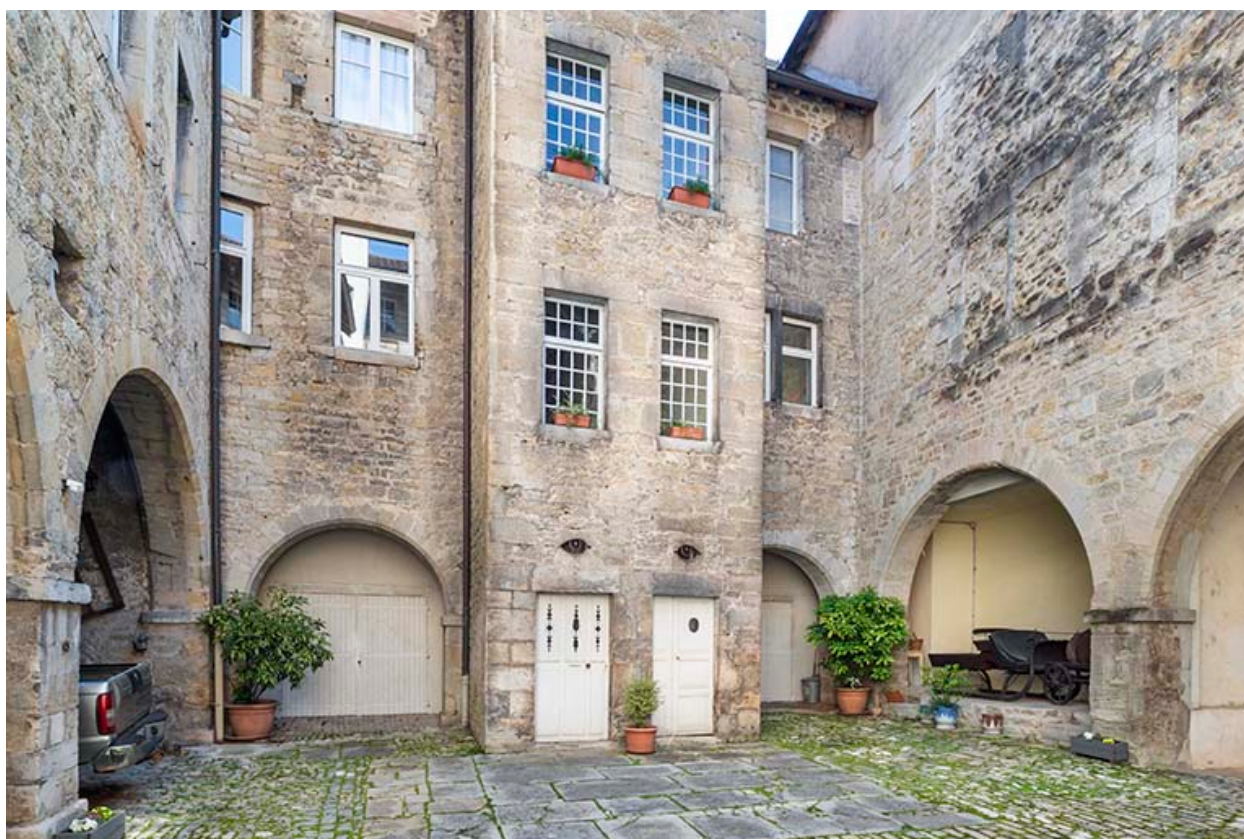
Première cour. Vue depuis le nord-ouest.
