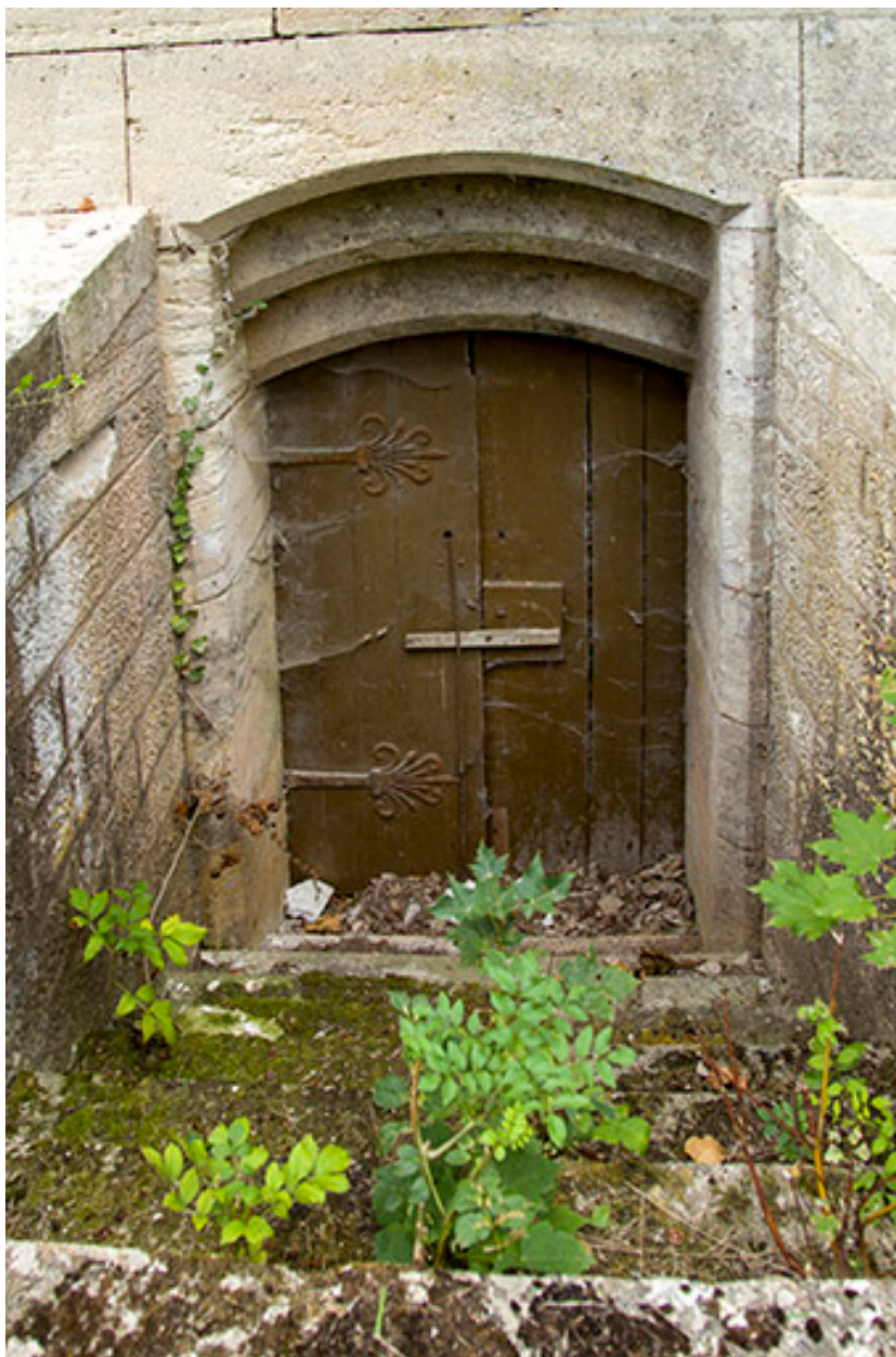
Détail : porte conduisant au sous-sol.
