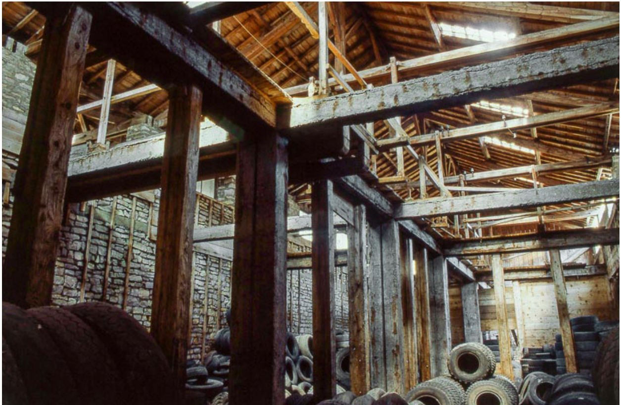
Intérieur d'un magasin industriel.
