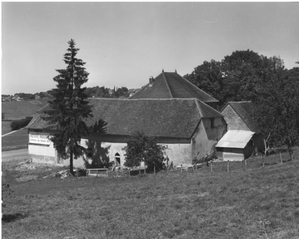
Relais de poste située au lieudit Mauffans.
