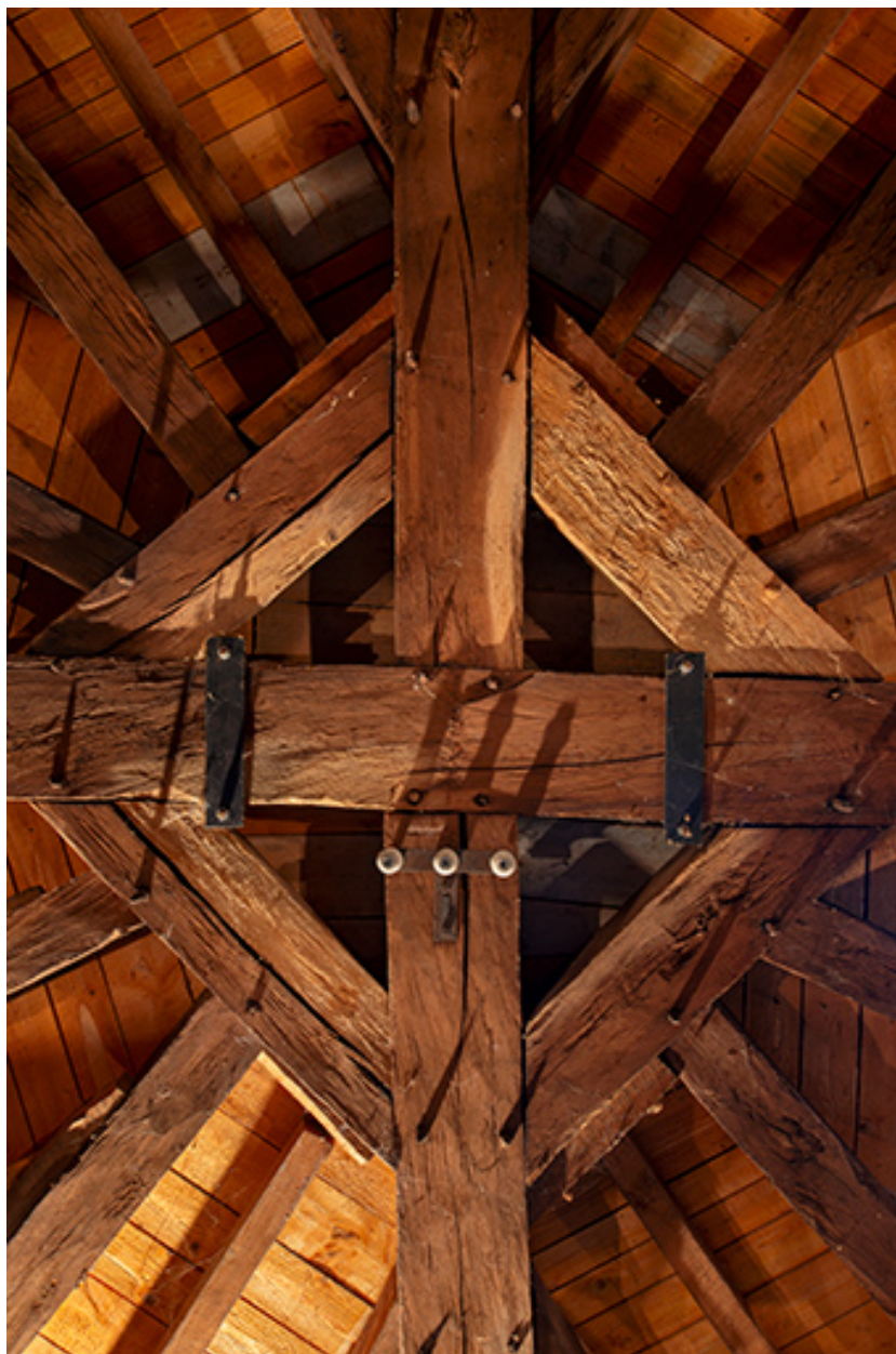
Charpente du dôme. Enrayure centrale.
