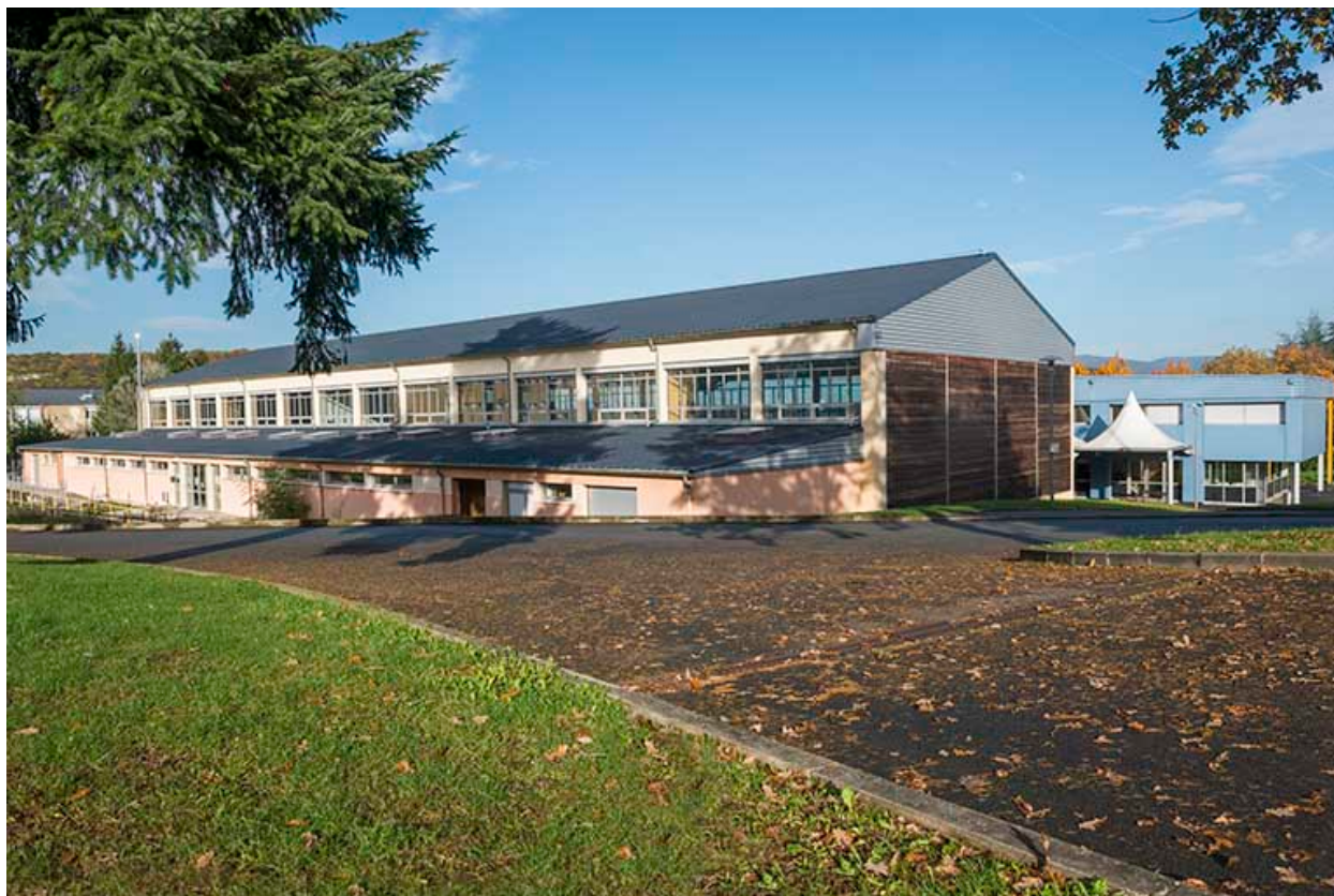
Angle sud-est du gymnase.
