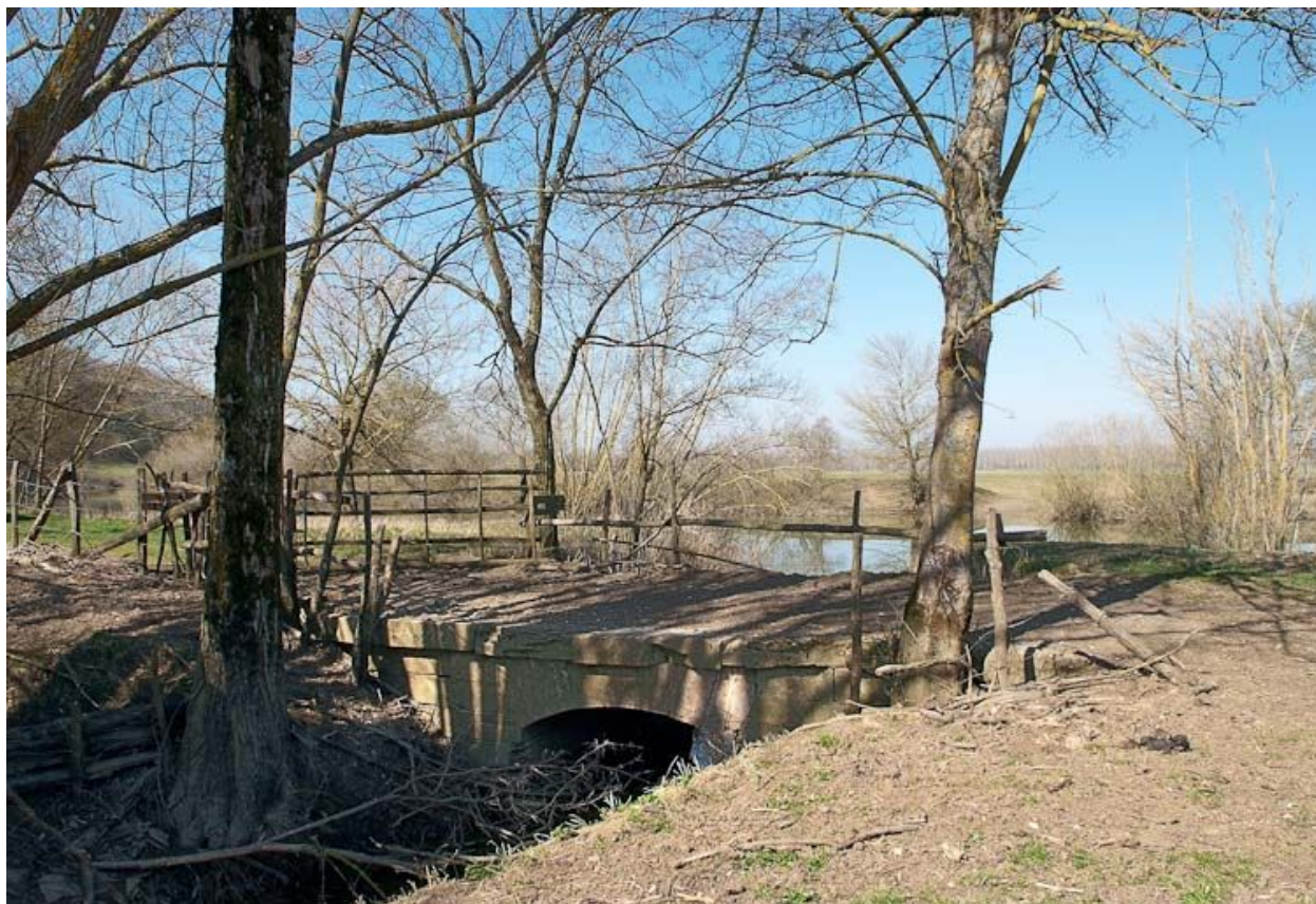
Ponceau : vue rapprochée.
