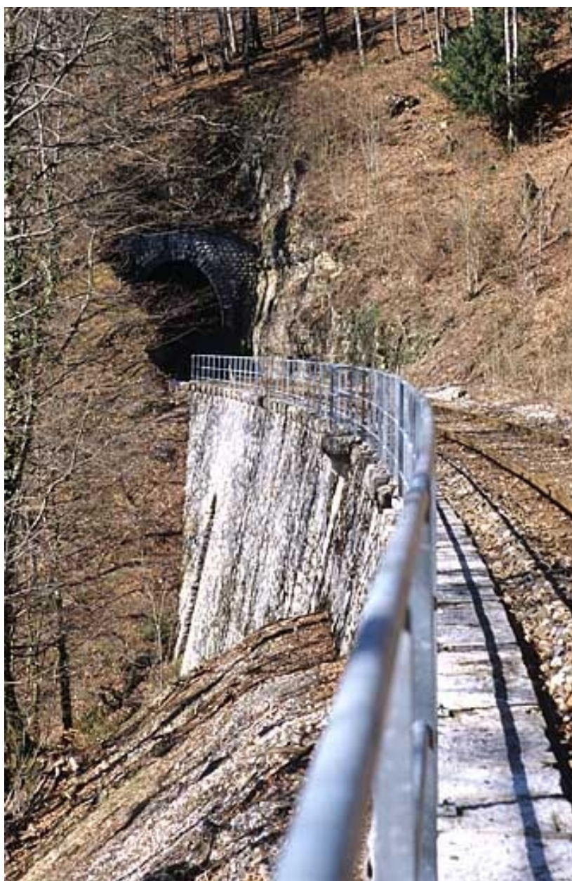
Tunnel de Lézair : tête côté Andelot-en-Montagne (nord-est). Cette tête est précédée par un mur de soutènement à gauche de la voie.
