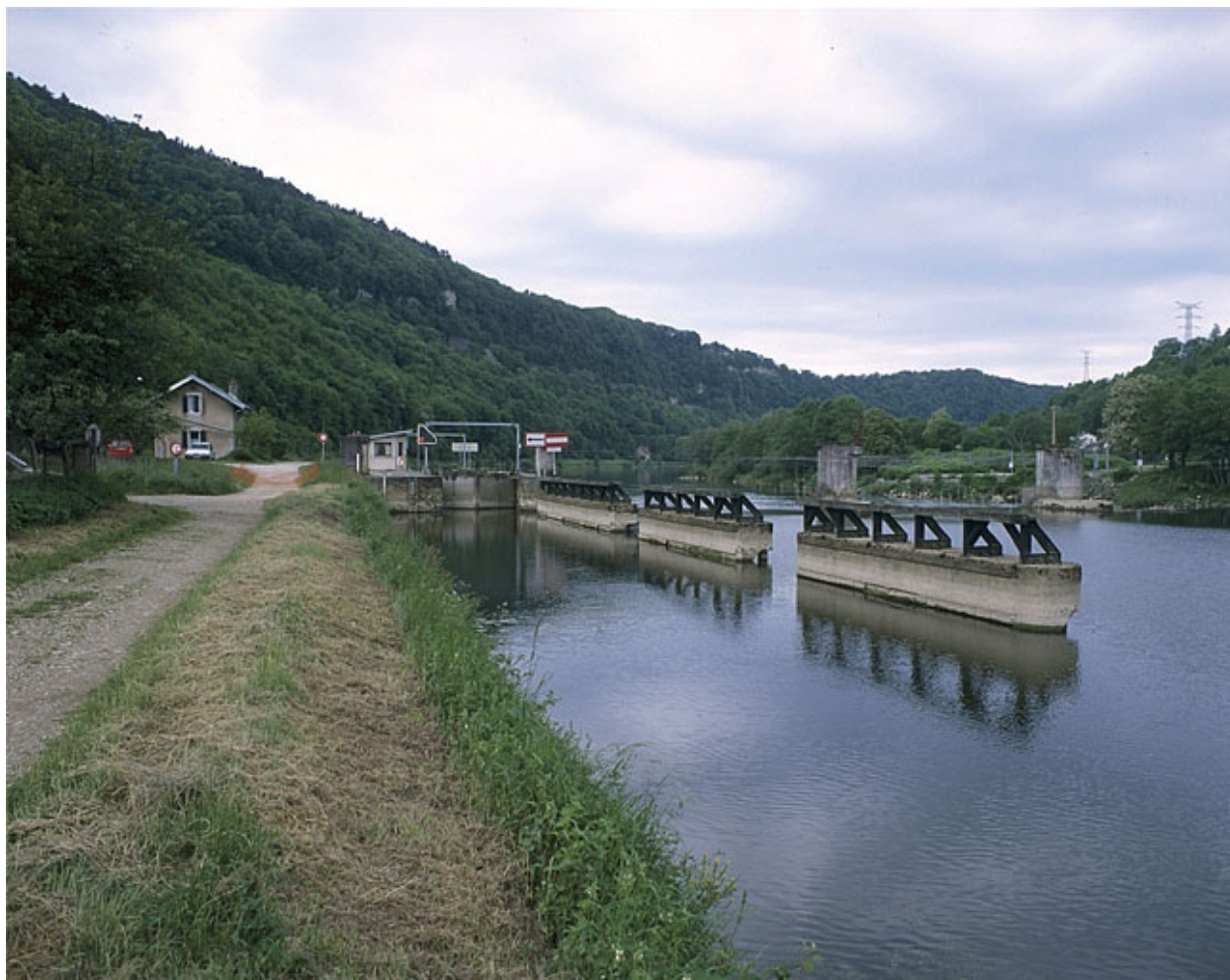
Vue d'ensemble depuis l'amont.
