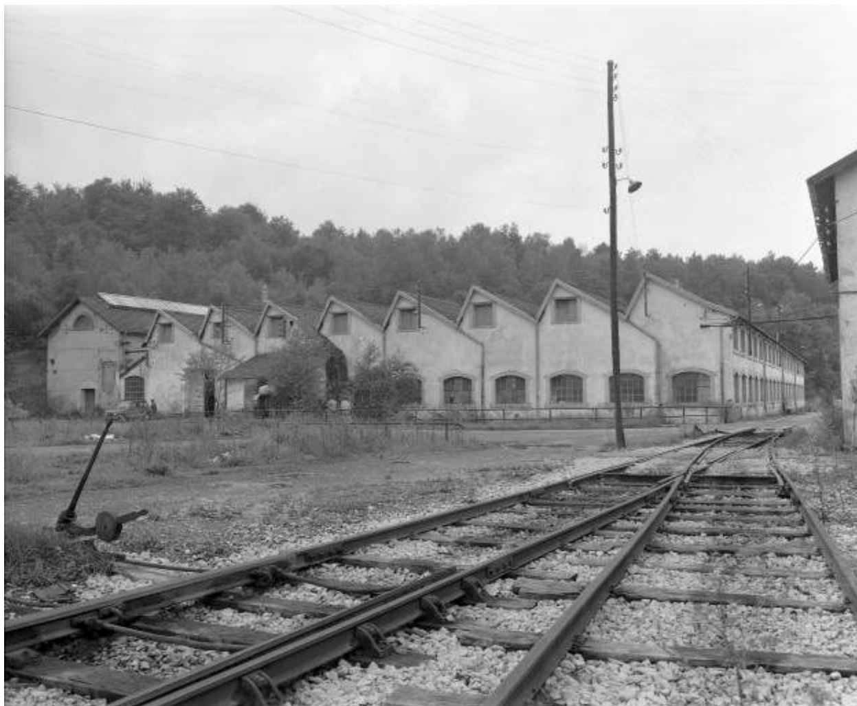
Atelier des pompes depuis l'est en 1981.
