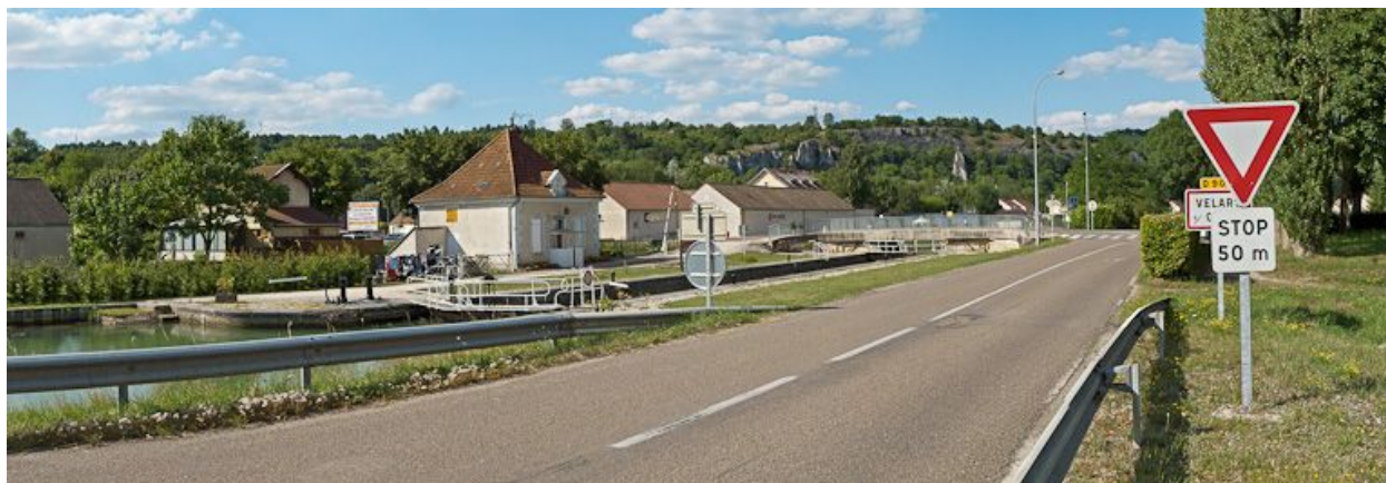
Vue d'ensemble du site d'écluse.
