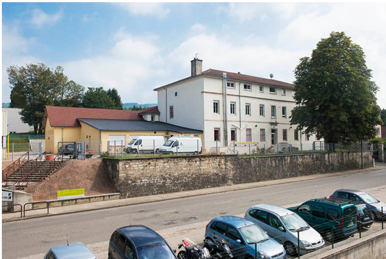
Internat : façade antérieure sur rue Lamartine.
