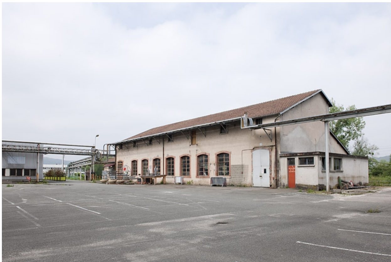
Bâtiment industriel. Vue de trois quarts.
