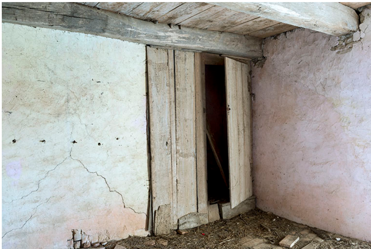
Porte pour accéder à l'étage du pigeonnier.
