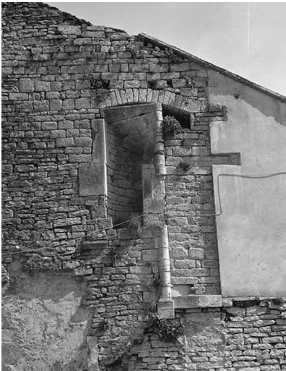
Vestige d'escalier en façade d'une maison : vue de face.
