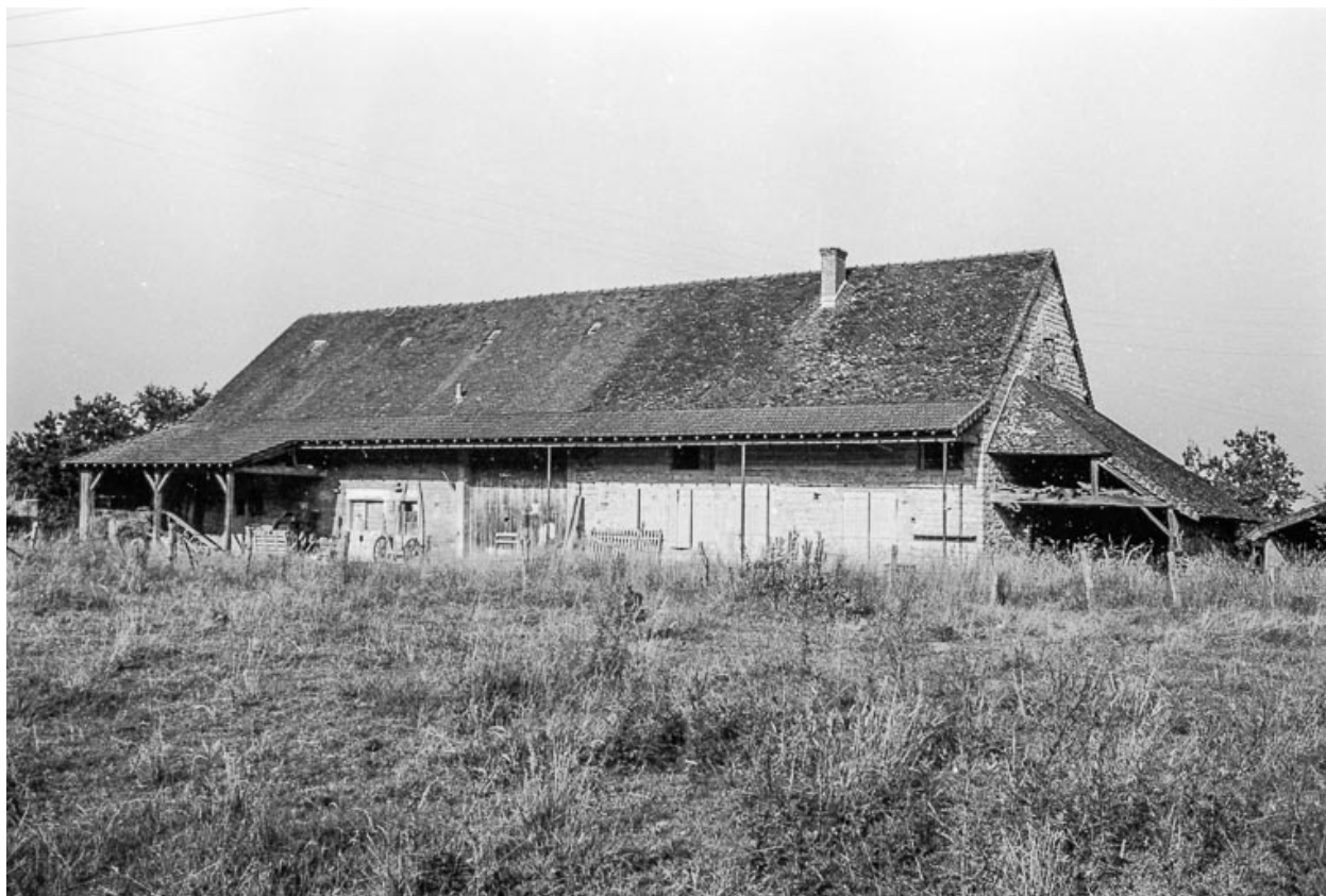
Ferme cadastrée 1956 A2 424 : façade antérieure.
