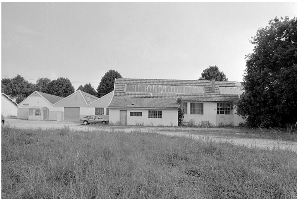
Ateliers de fabrication depuis le sud.
