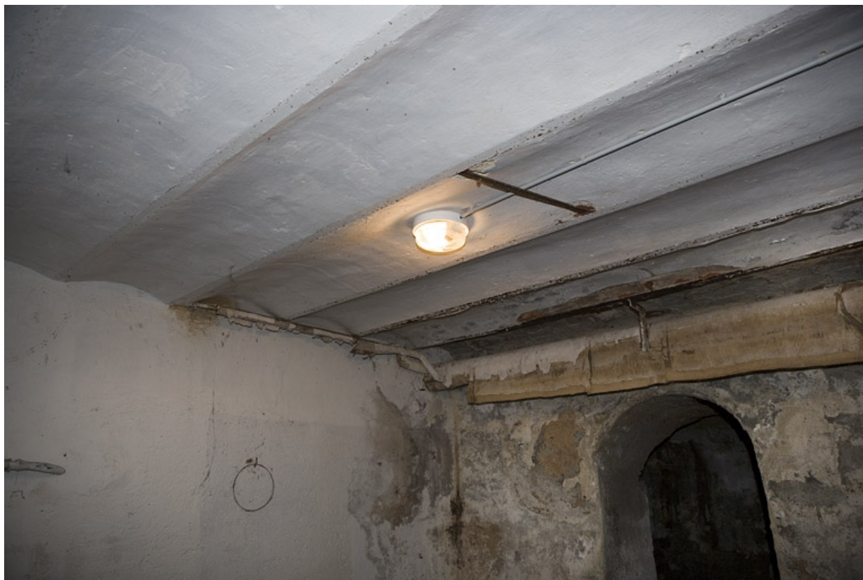
Bâtiment A : sous-sol. Détail voûtais.
