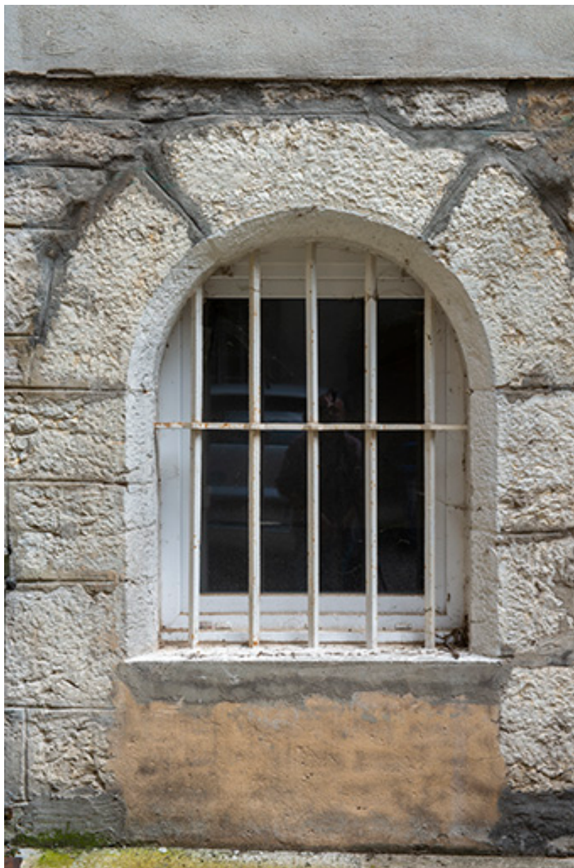
Façade est. Baie en plein-cintre du rez-de-chaussée.
