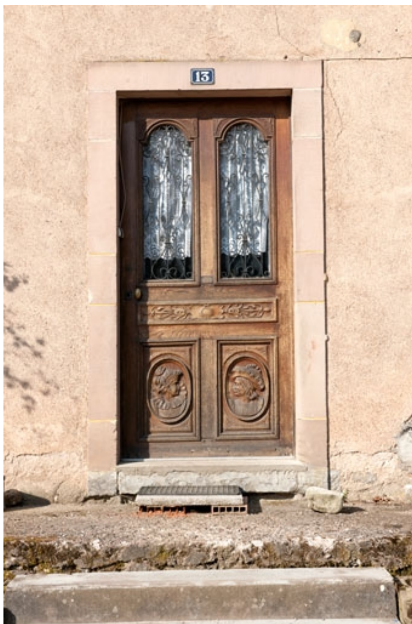
Logis (côté rue) : porte d'entrée.
