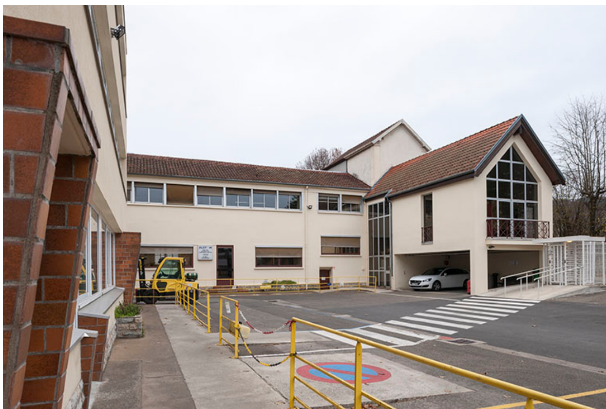
Bâtiments d'entrée (conciergerie et bureaux).
