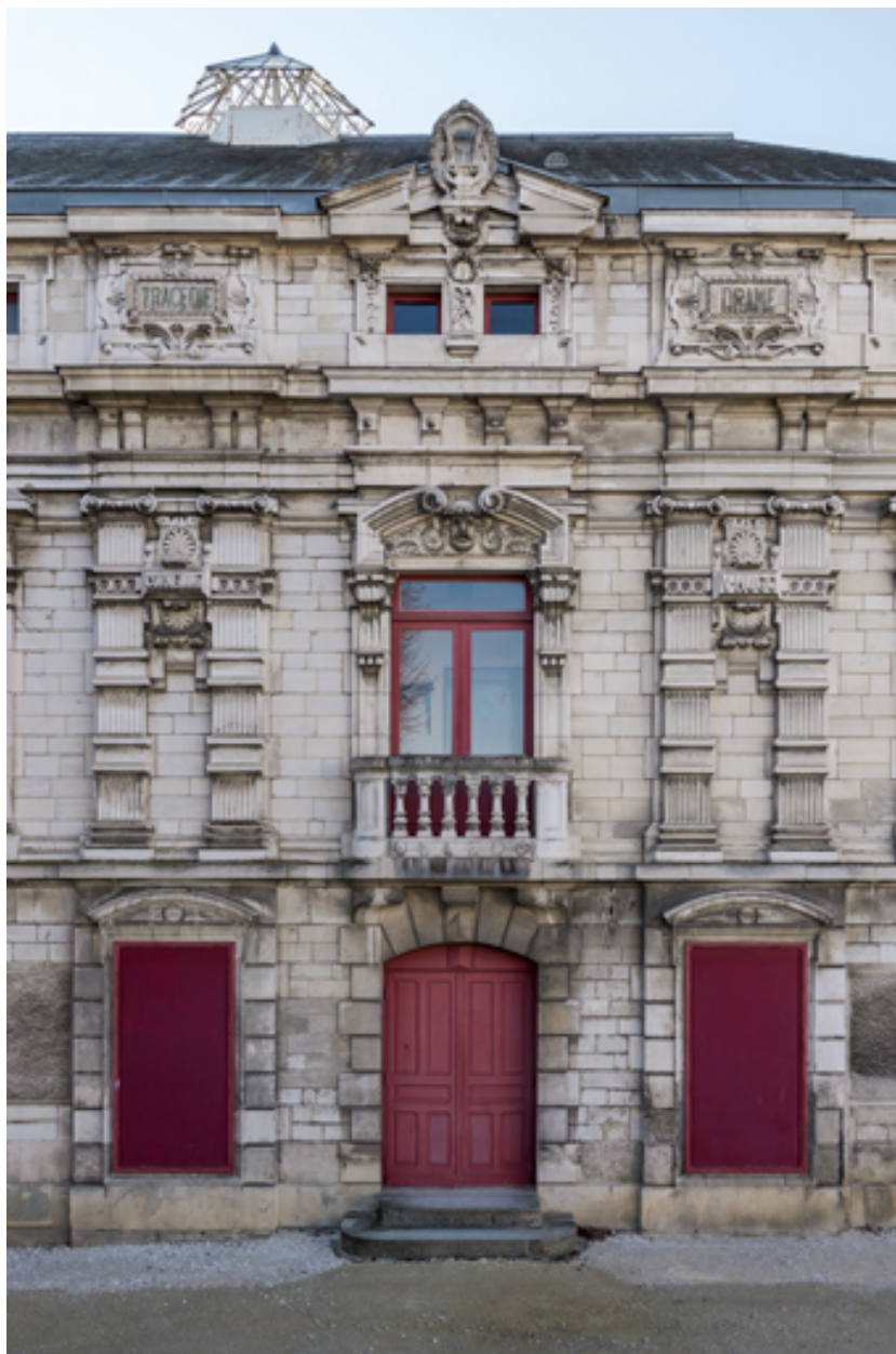
Façade latérale gauche : travées centrales.
