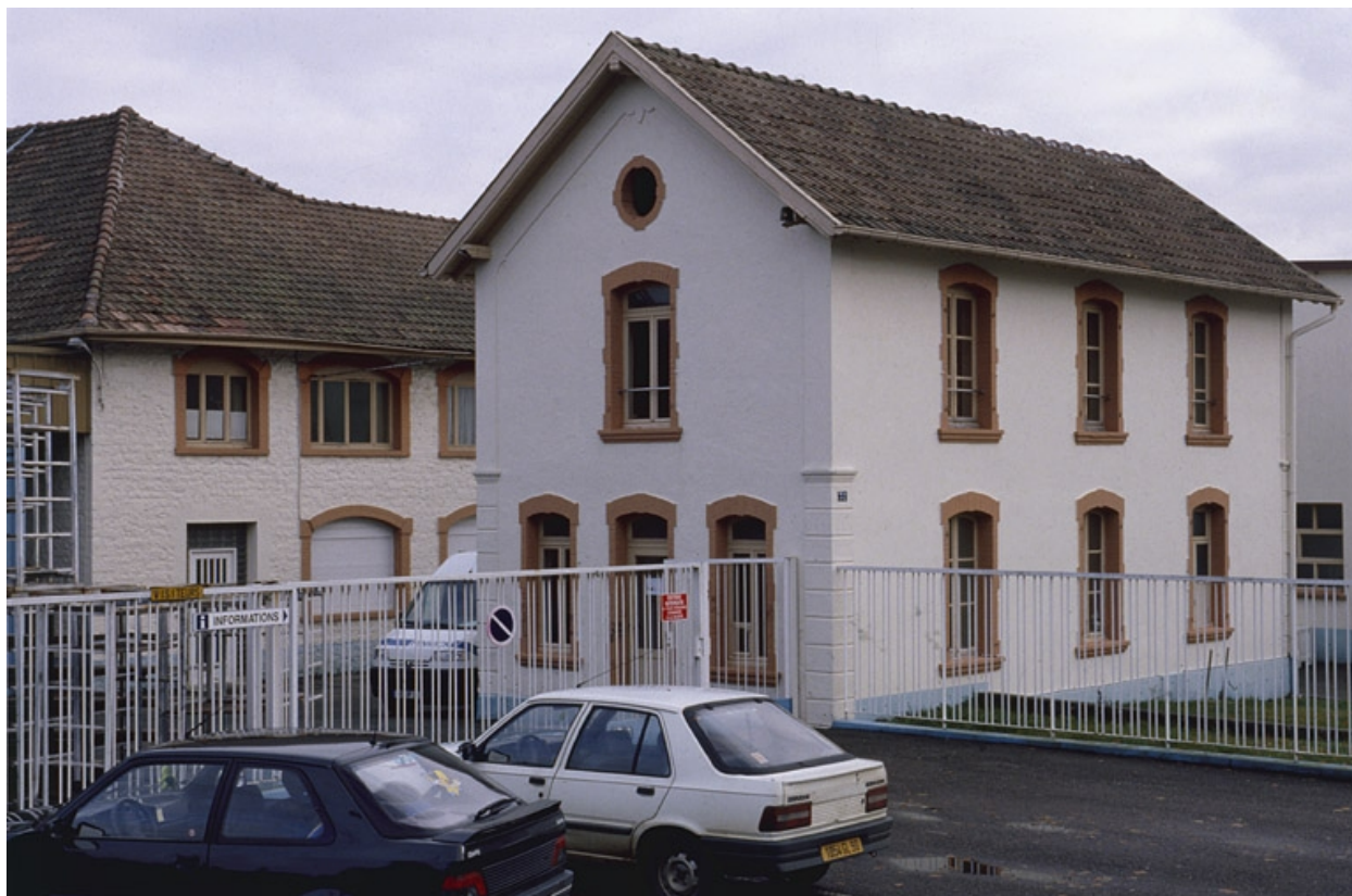
Anciens bureaux (?) de l'usine de teinturerie.
