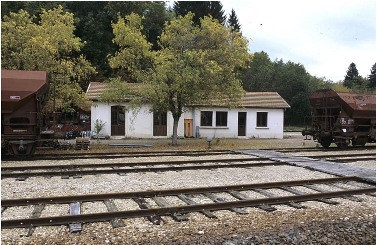
Ancienne lampisterie (bureau des électriciens), de face.
