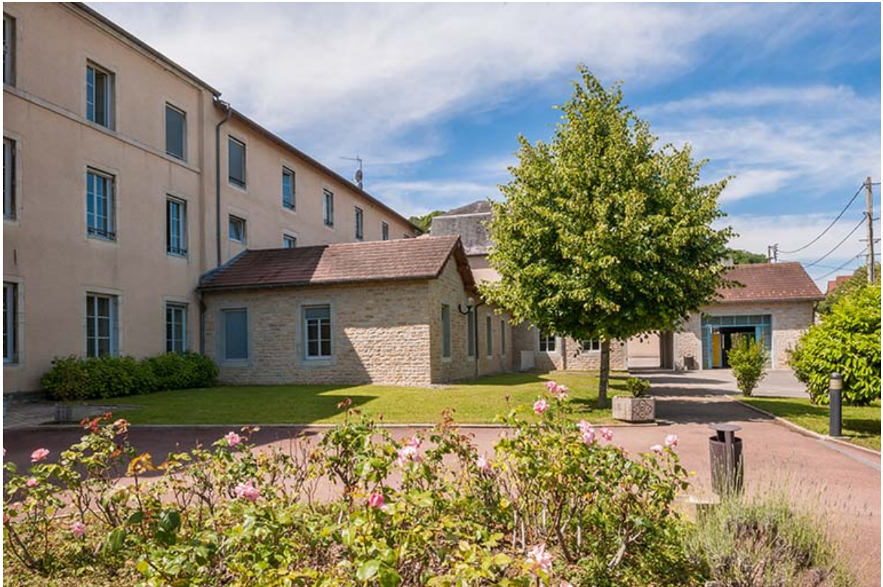
Façade postérieure de l'externat
