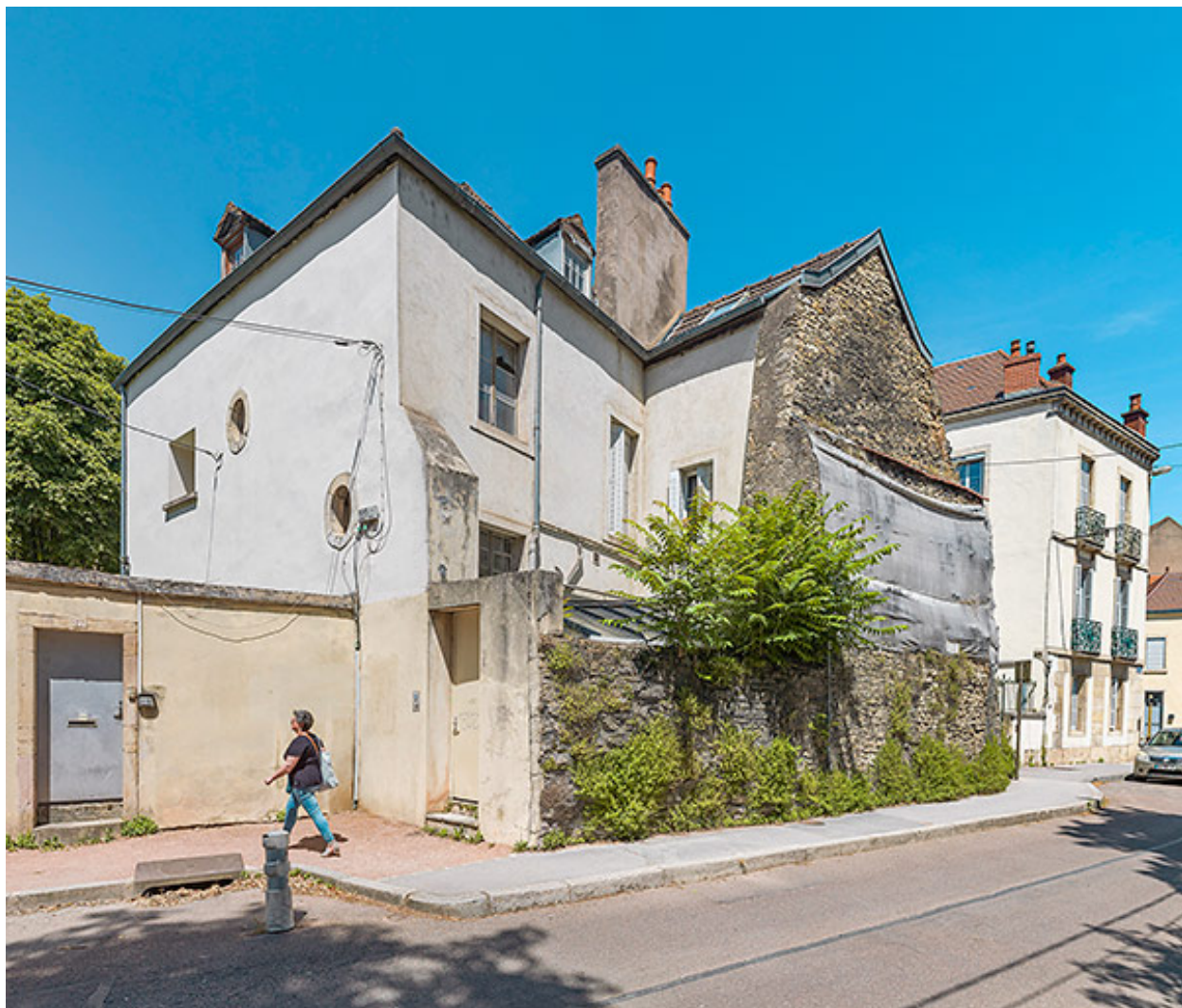
Tronçon du rempart, rue Berlier.
