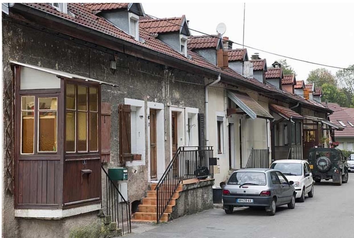
Façade est du logement sud (caserne B).
