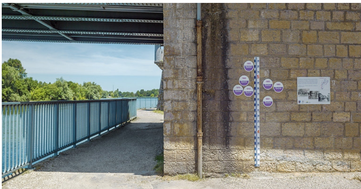
Détail des repères de crues.
