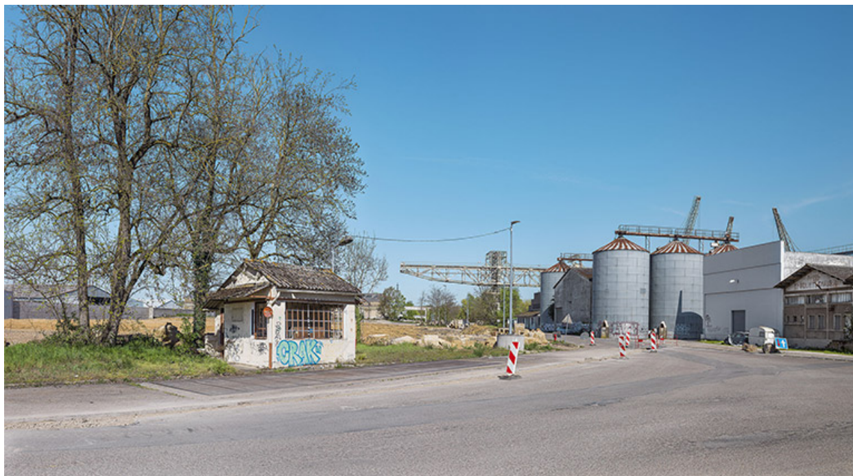
Pont-bascule (routier) et son poste de commande (désaffecté).
