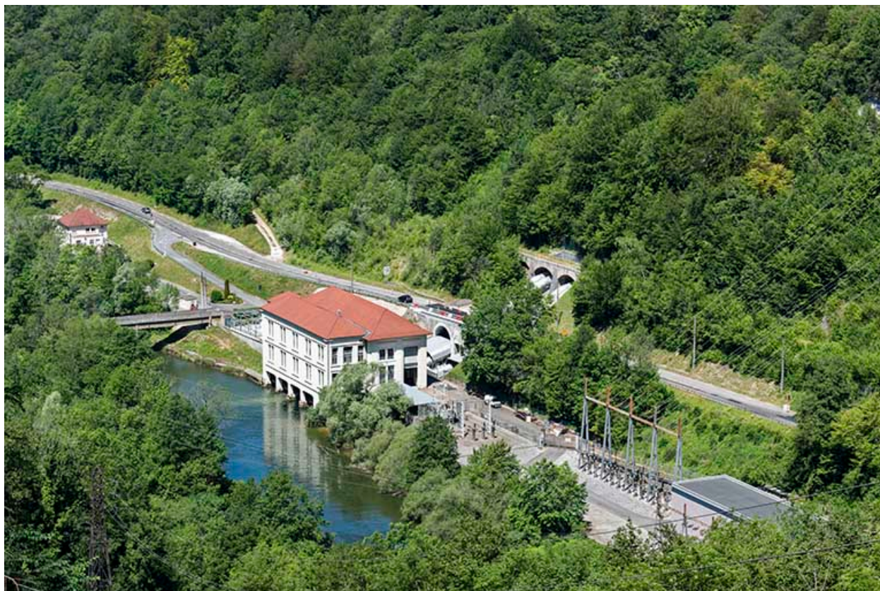
Vue d'ensemble plongeante, depuis le sud-est.
