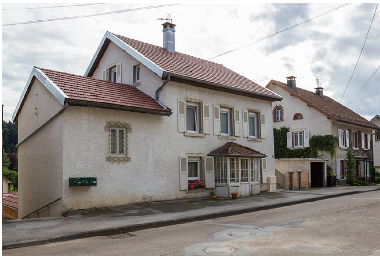
Façades antérieure et latérale gauche.
