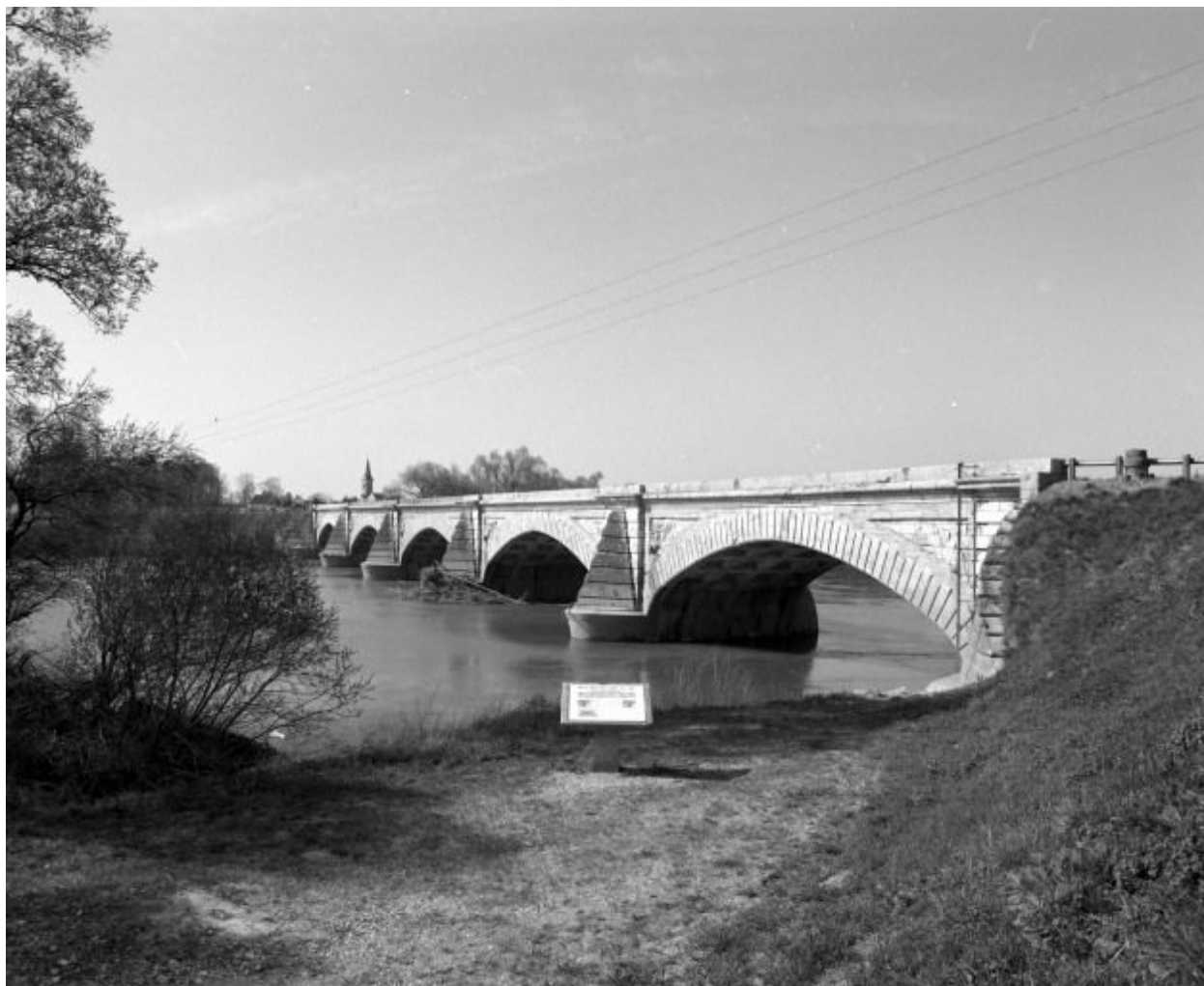
Vue d'ensemble en amont.
