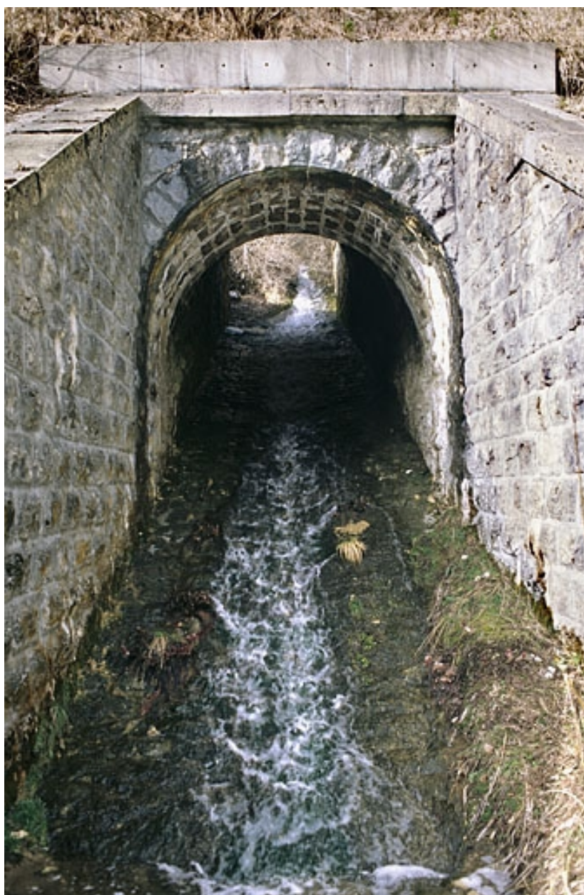
Pont : vue d'ensemble, depuis le sud (aval).
