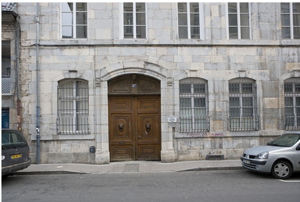
Détail du rez-de-chaussée de la façade principale.
