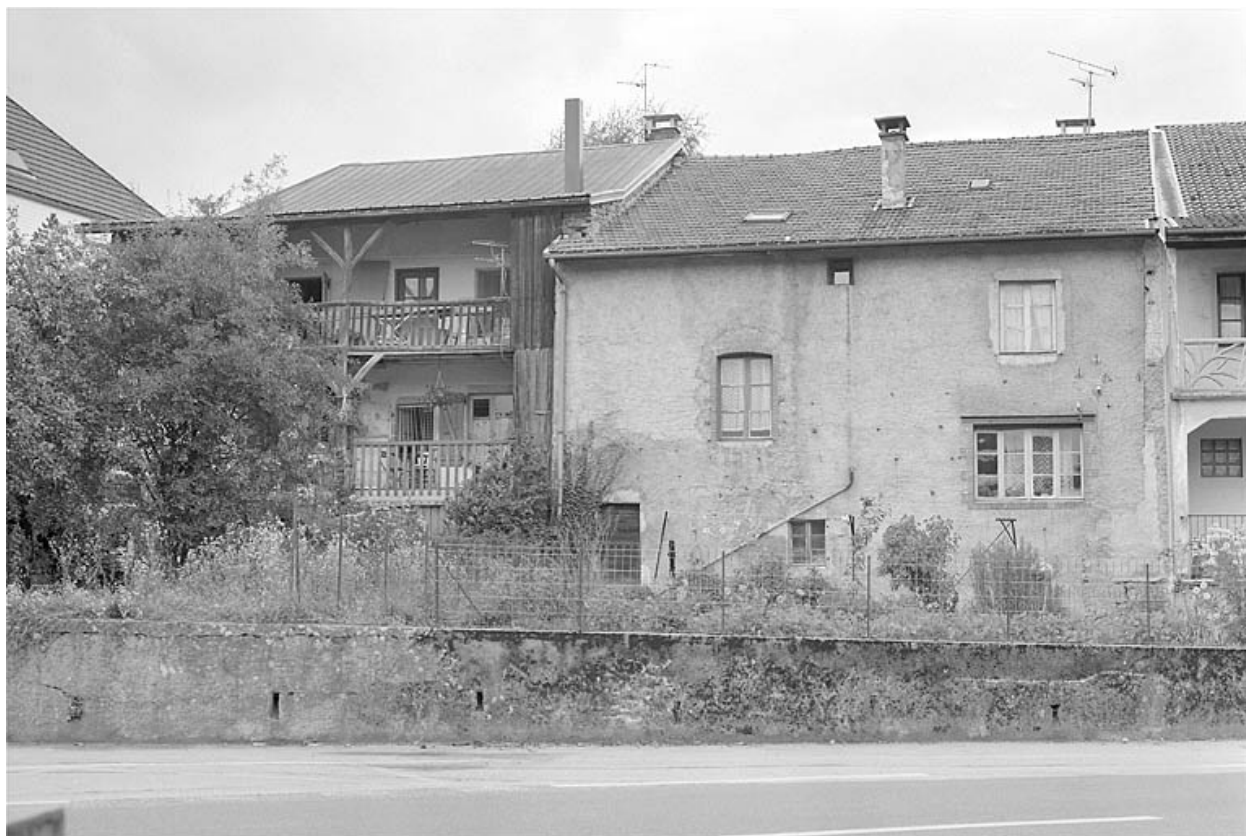
Grande Rue, façades postérieures d'anciennes fermes.
