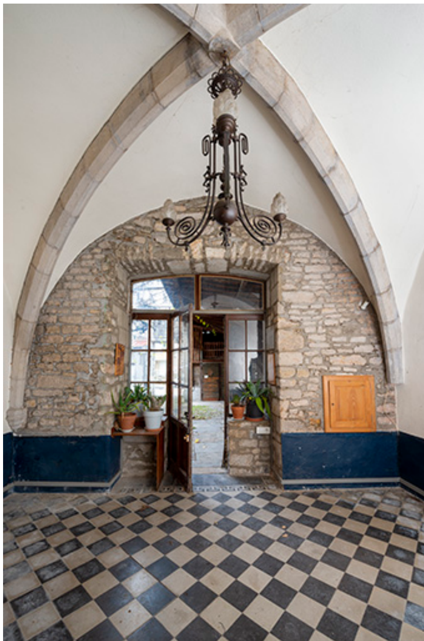
Pièce voûtée (rez-de-chaussée de la tour).
