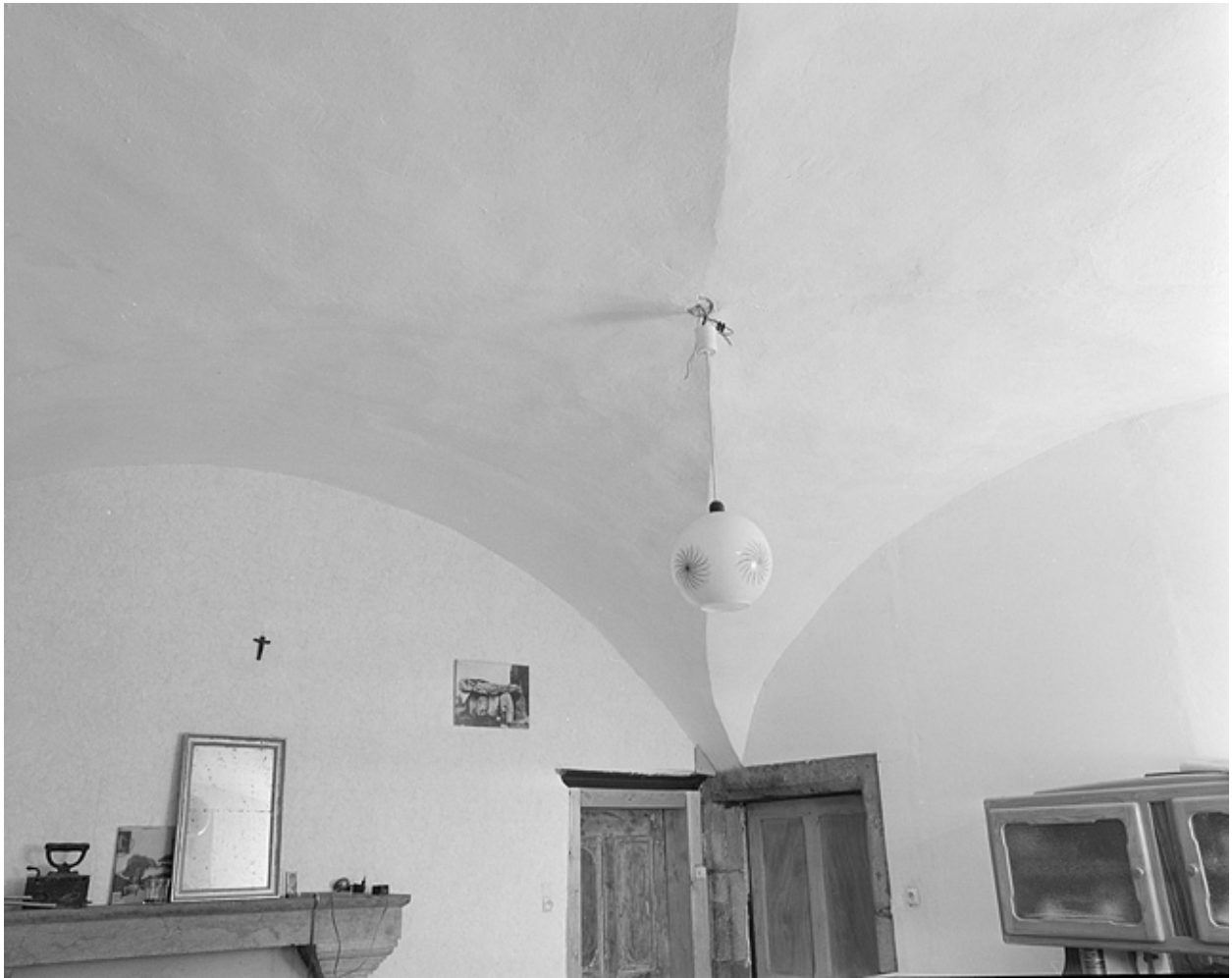
Pièce du rez-de-chaussée, voûte d'arêtes.
