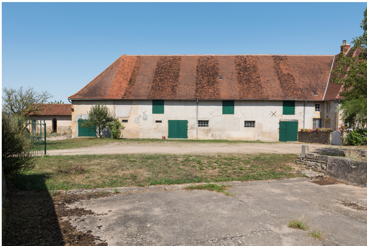
Facade postérieure (sud-est) de la ferme.
