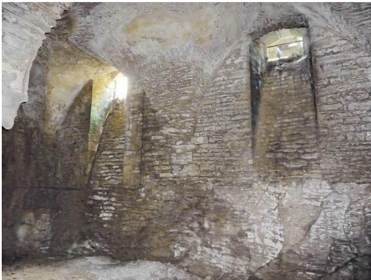
Cave sous la grange : voûte et soupiraux.
