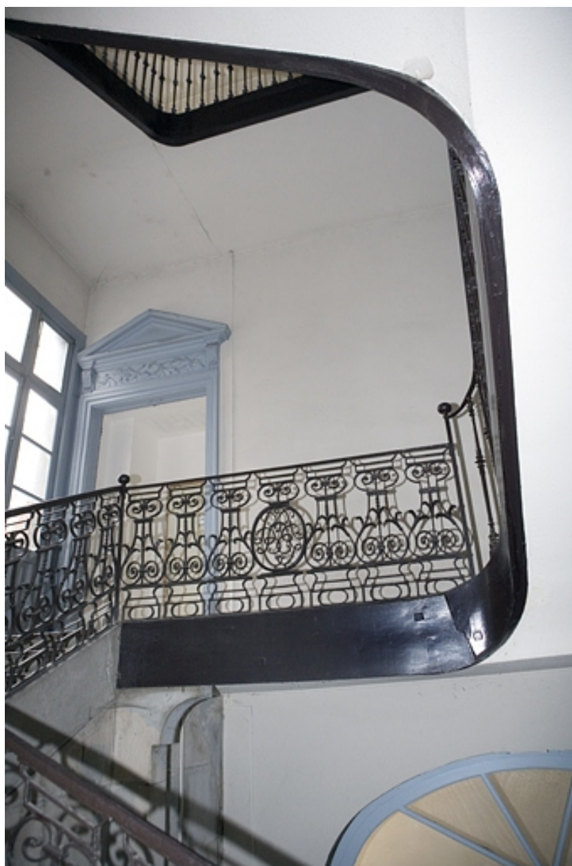
Détail de la rampe de l'escalier.
