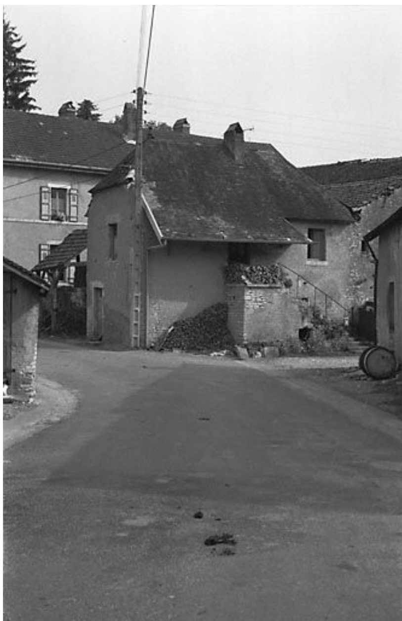
Maison située rue de la Fontaine.
