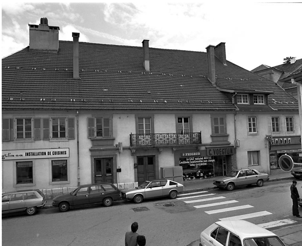
Maison située 9 rue de la Halle.
