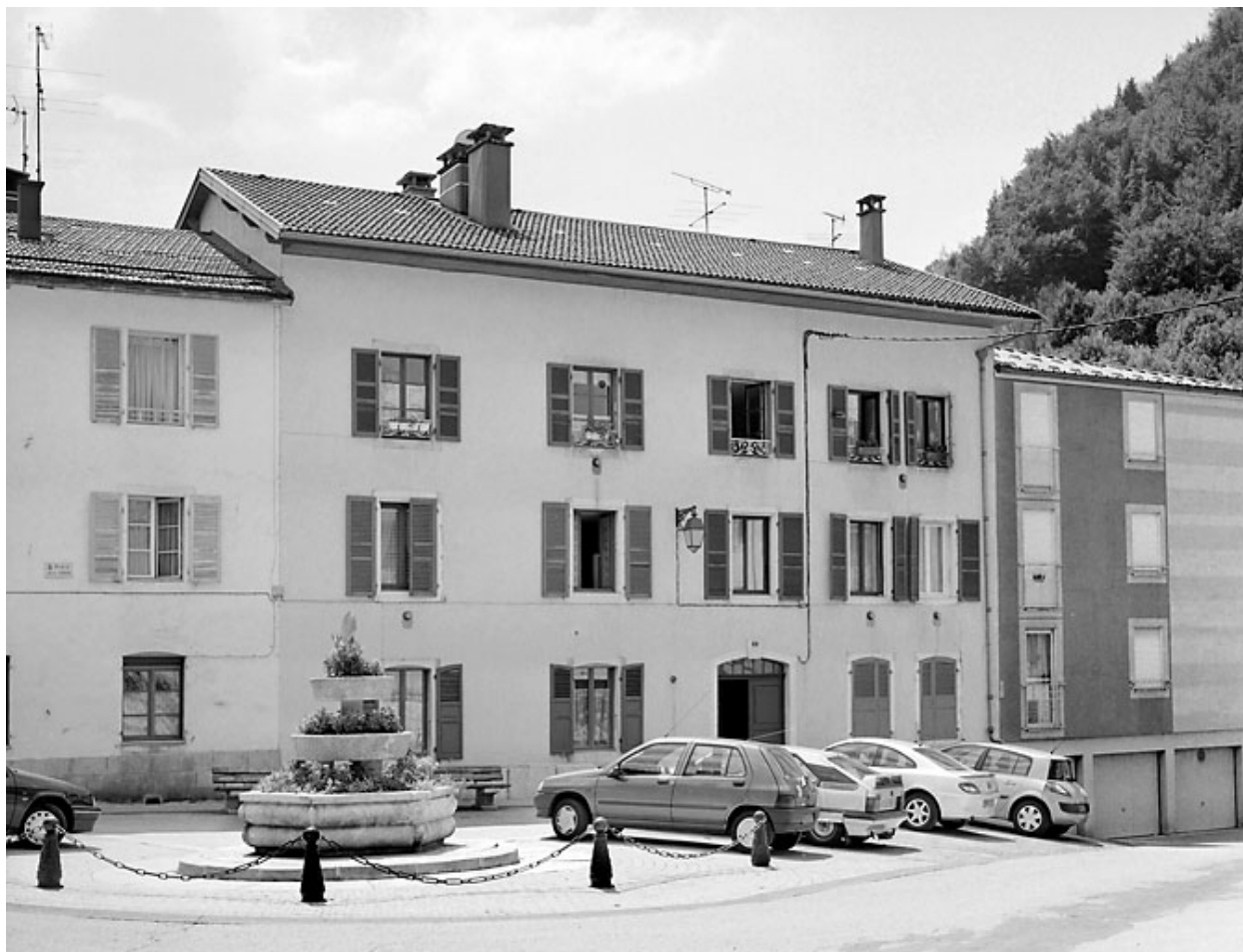
Elévation antérieure, de trois quarts gauche.
