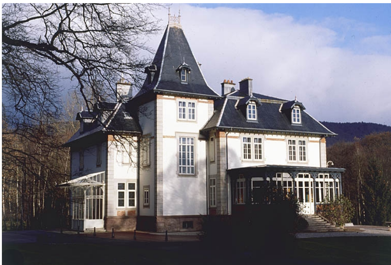
Façades sud du logement patronal.
