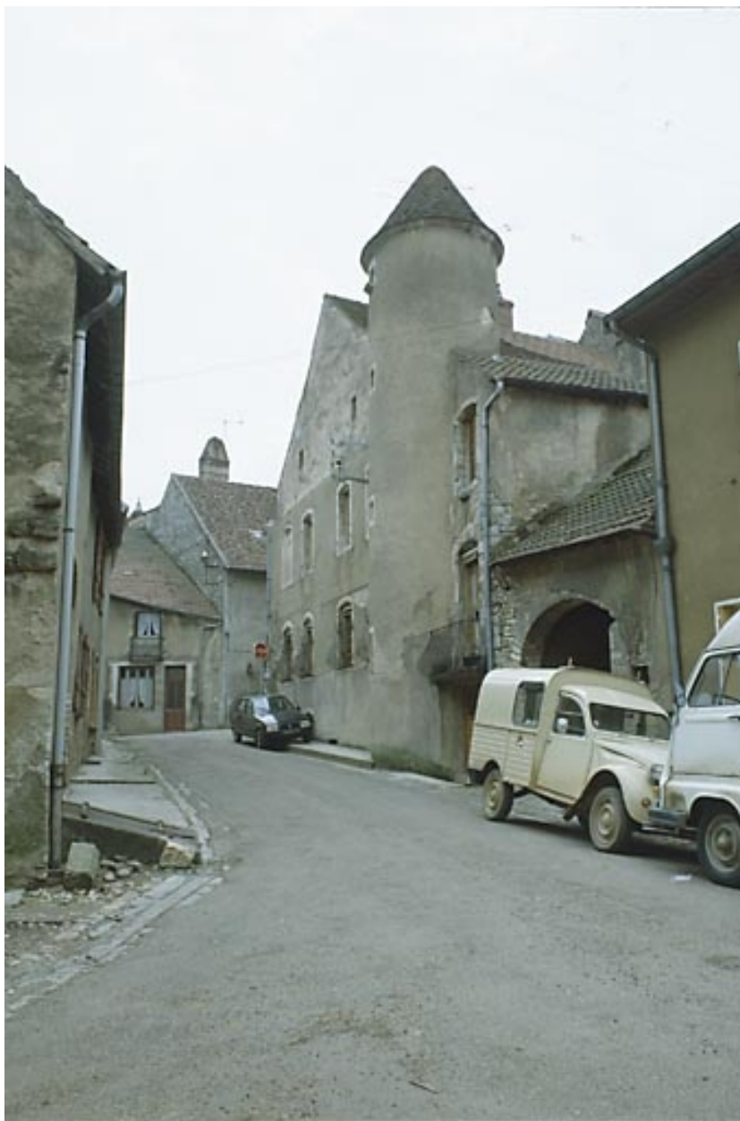
Maison située rue Gambetta.
