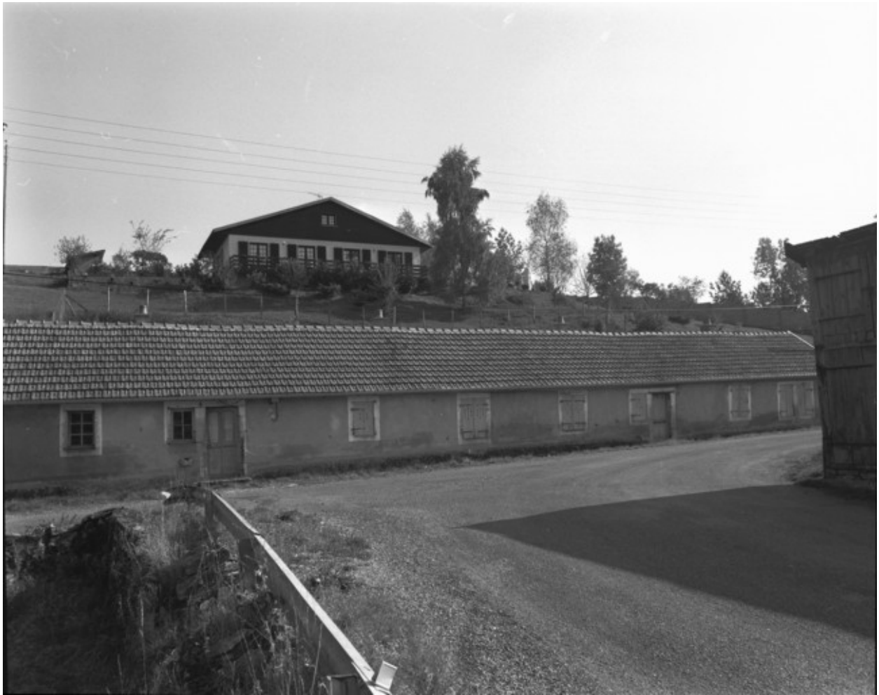
Façade ouest du logement ouvrier de la forge de Petit Baignes en 1989.
